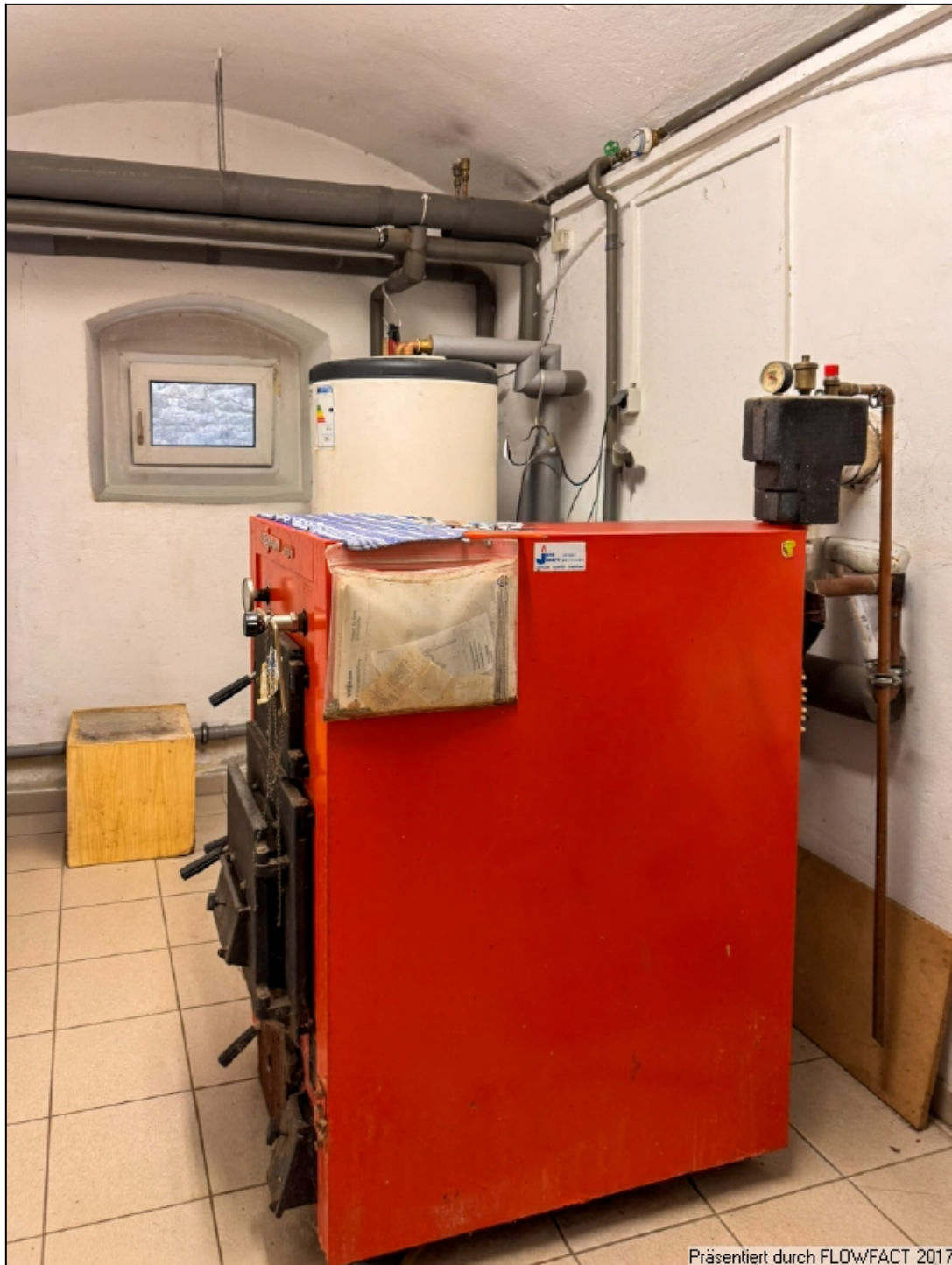
Festbrennstoff-Kessel Mehrfamilienhaus
