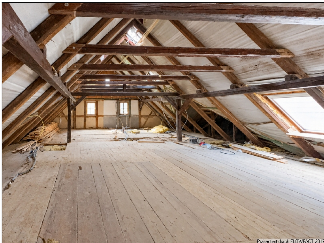
Dachgeschoss Gashauss Rückbau
