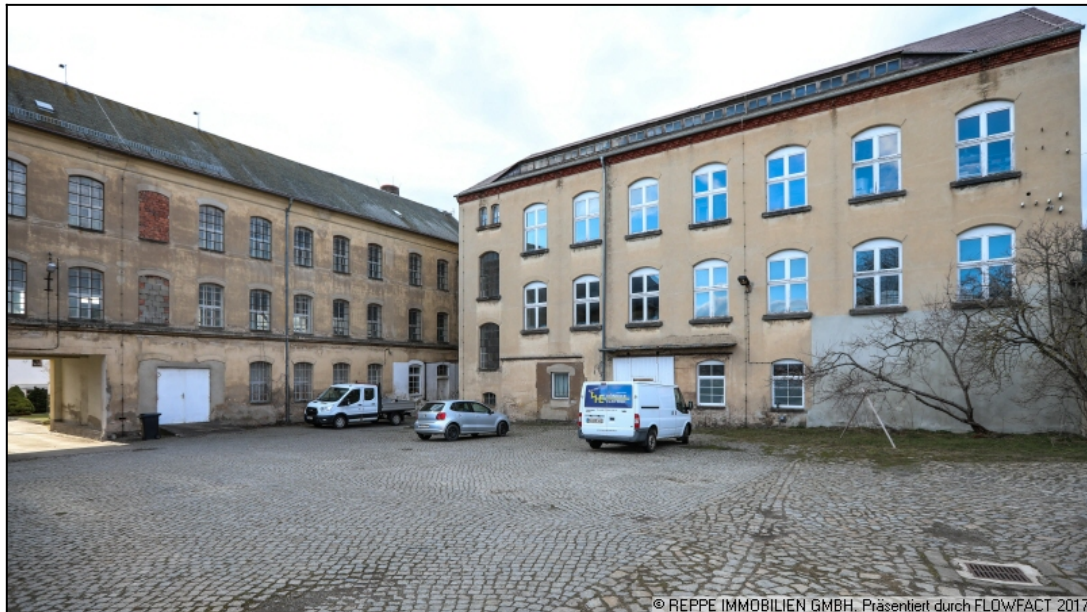
Süd Ansicht Innenhof Gebäude 2 und 3
