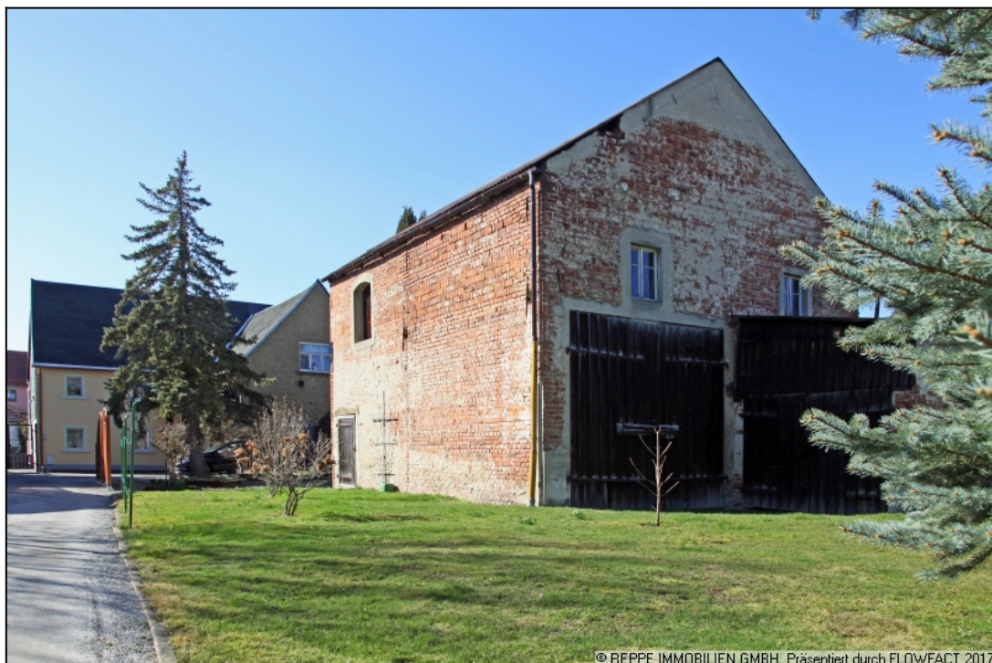
Blick auf die Scheune
