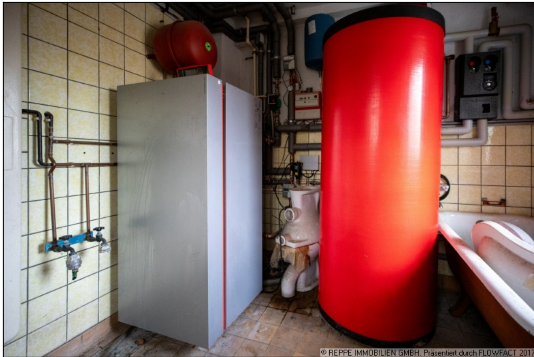
Zentralheizung mit Pufferspeicher
