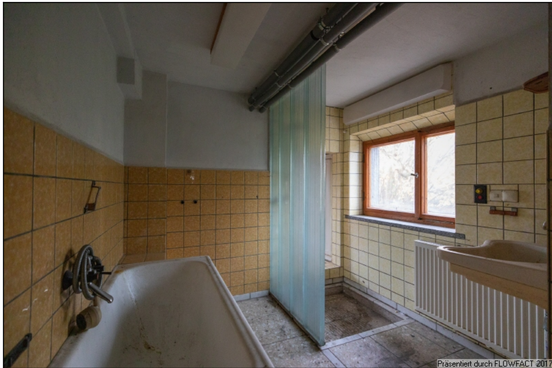
Bad im Anbau
