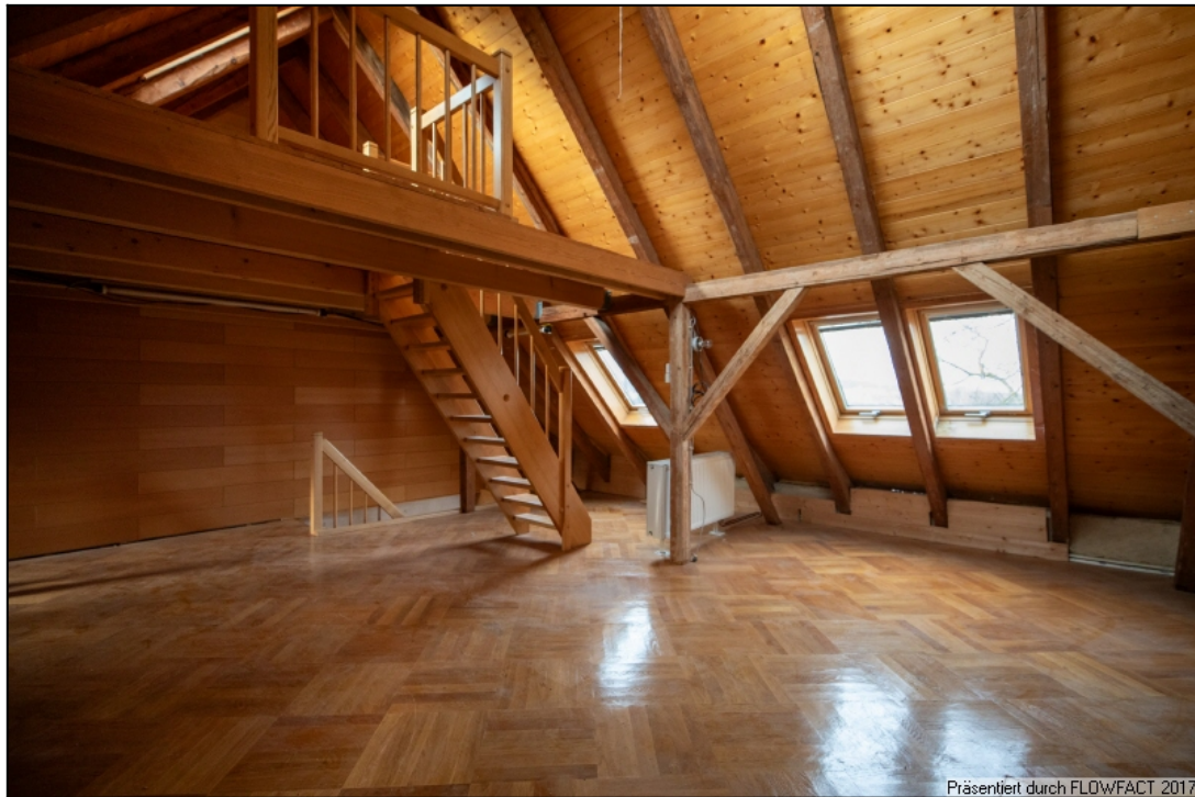
Dachgeschoss ausgebaut und gedämmt
