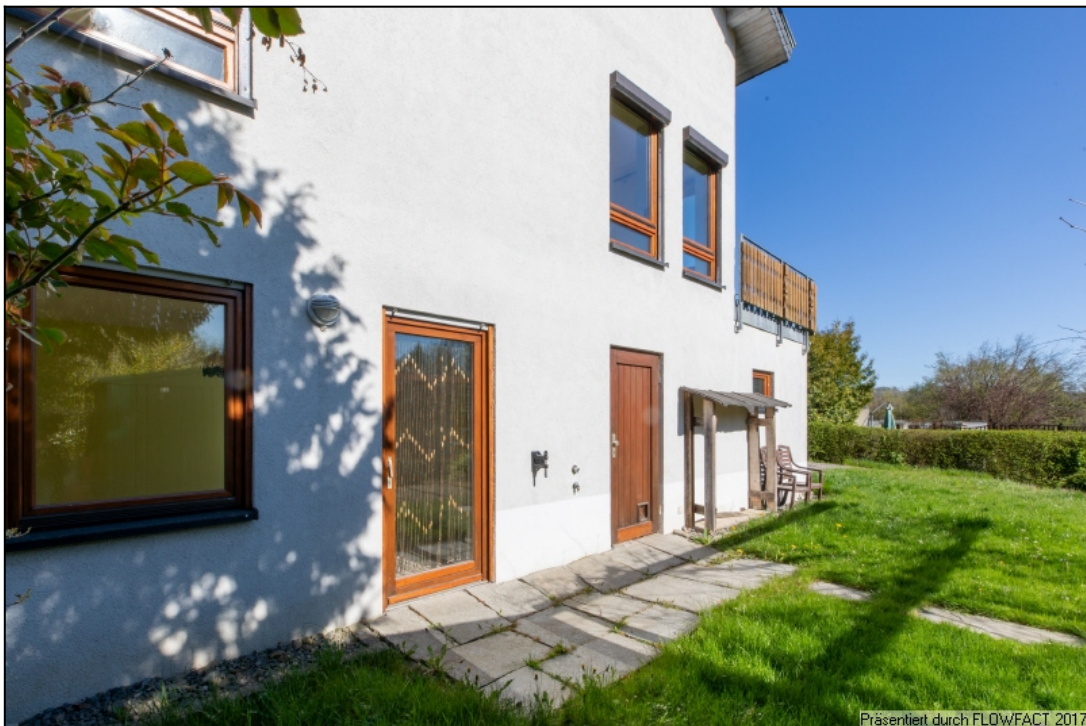
Zugang zum Kellergeschoss
