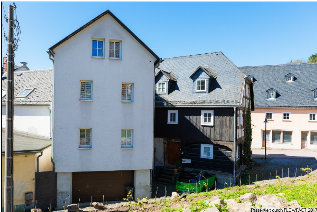
Ansicht mit Anbau
