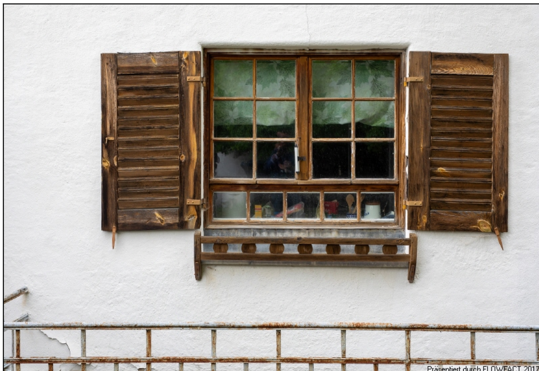
Detail Fenster Küche
