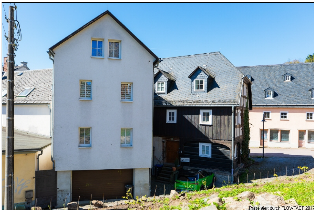
Ansicht mit Anbau
